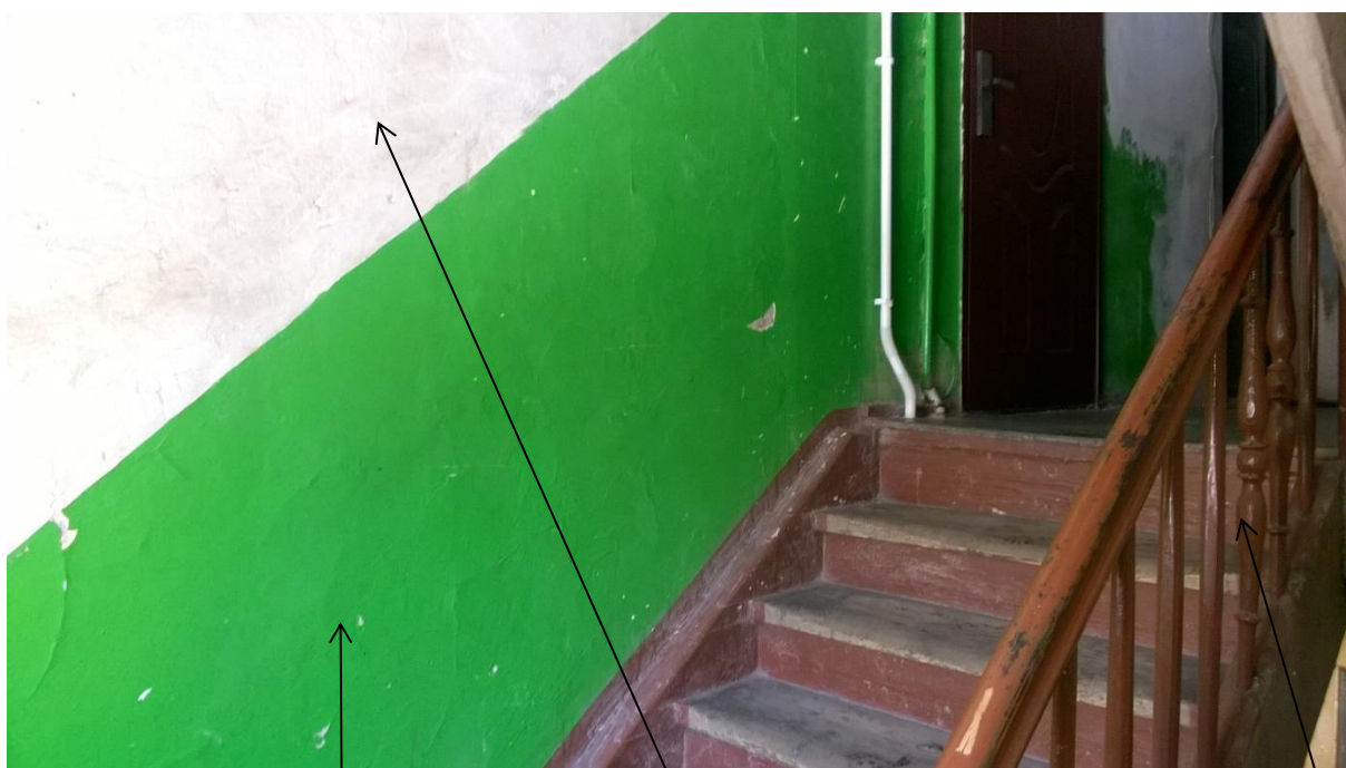
olejnica na tynkach ścian
