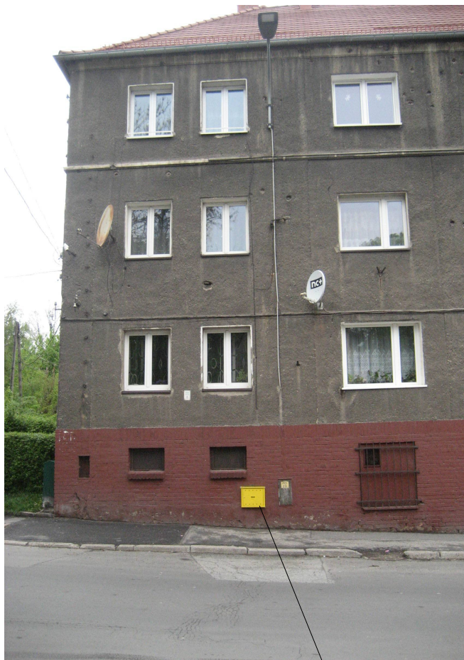
Istn. wnekowa skrzynka gazowa o wym 500x400x250 z istn. kołnierзовym GKG dn50
