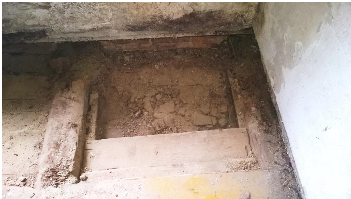
fot. nr 1 całkowite zniszczenie dwóch belek stropowych
