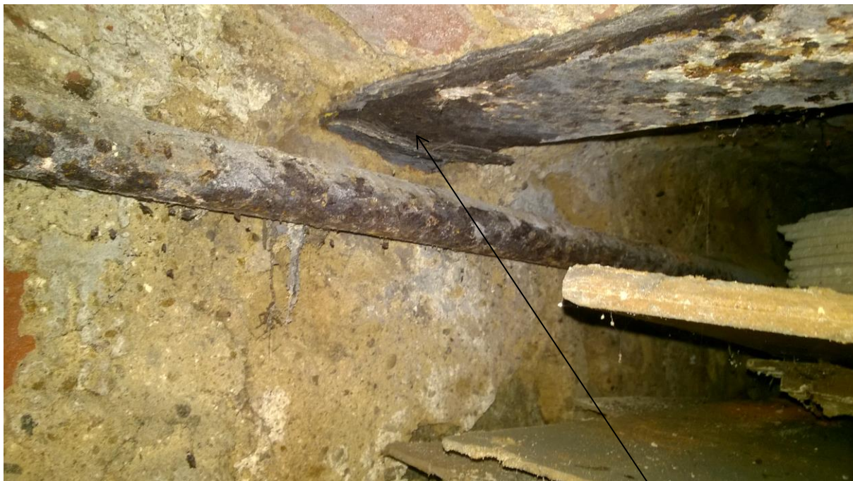
fot 3 silna korozja rozwarstwiająca dolne półki belek strefy przypodporowej
