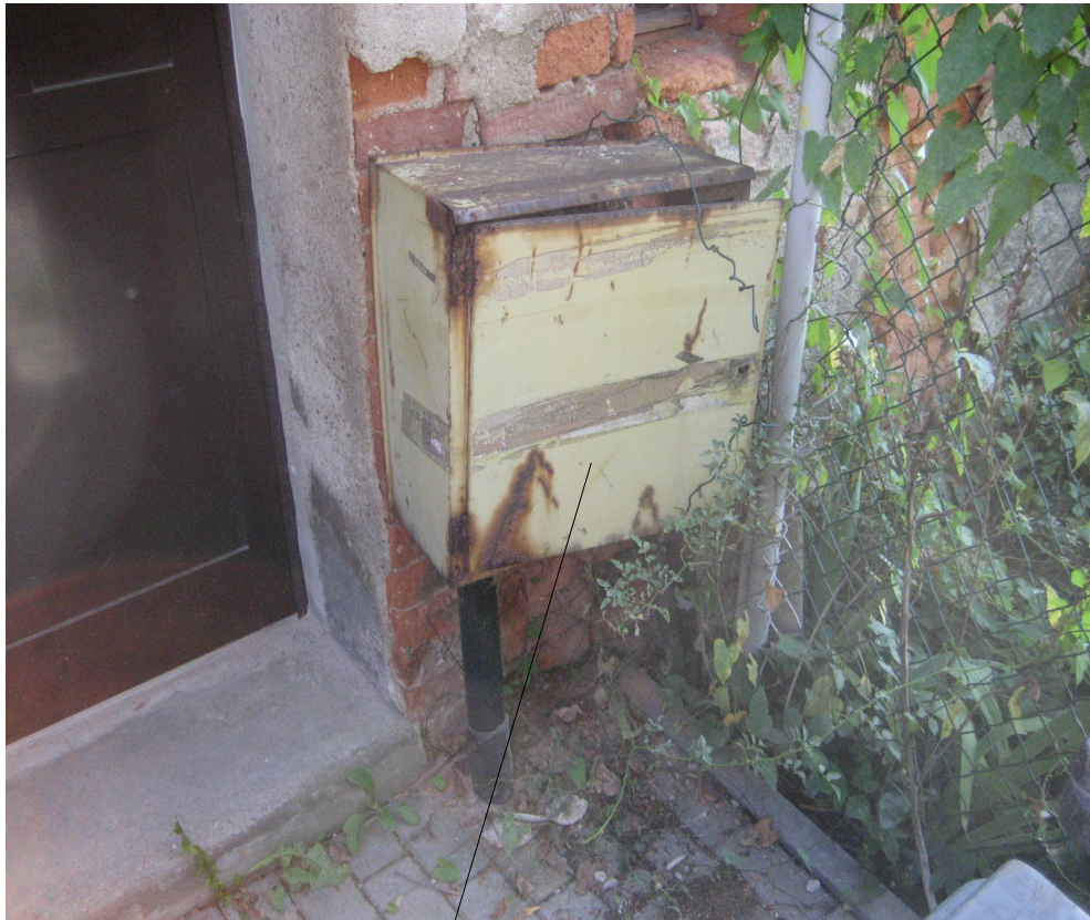
Istn. naścienna skrzynka gazowa o wym. 500x500x250mm (do wymiany) z proj. kołnierzym GKG dn50
