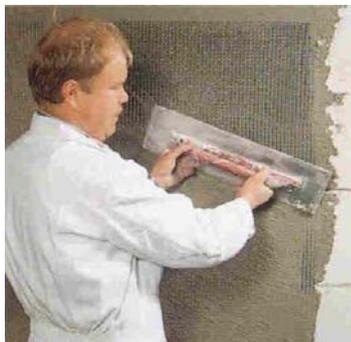
Tynk cienkowarstwowy na bloczkach z betonu komórkowego.
