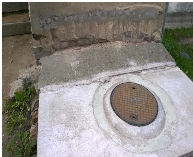
studzienka do demontażu i odtworzenia
