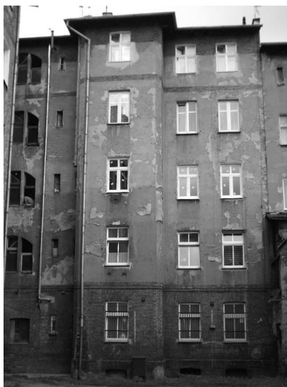
Elewacja tylna prawa: uszkodzone tynki, zniszczona stolarka okienna klatki schodowej
