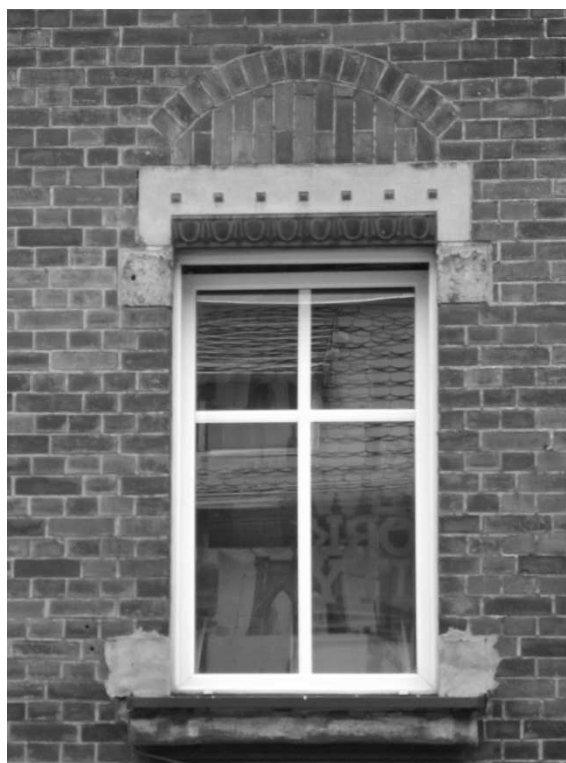
Elewacje frontowe – uszkodzenia sztukaterii, zanieczyszczenia cegieł
