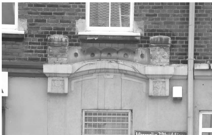
Elewacja frontowa lewa - uszkodzenia sztukaterii, zanieczyszczenia cegieł, zróżnicowanie kolorystyczne obróbek i elewacji w poziomie parteru
