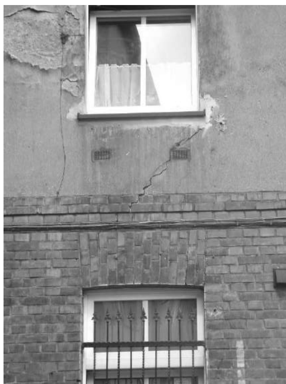
Pęknięcia ukośne na elewacji tylnej prawej (naprawa przez zatopienie prętów stalowych w spoinach)
