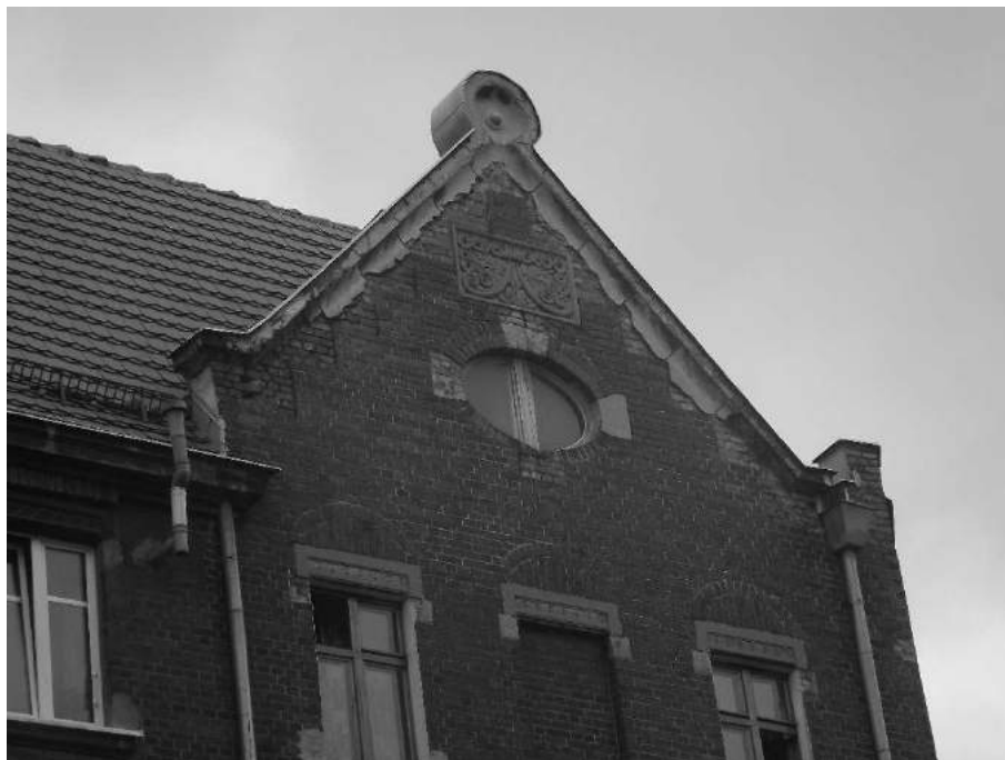
Uszkodzenia detali architektonicznych na elewacji frontowej lewej
