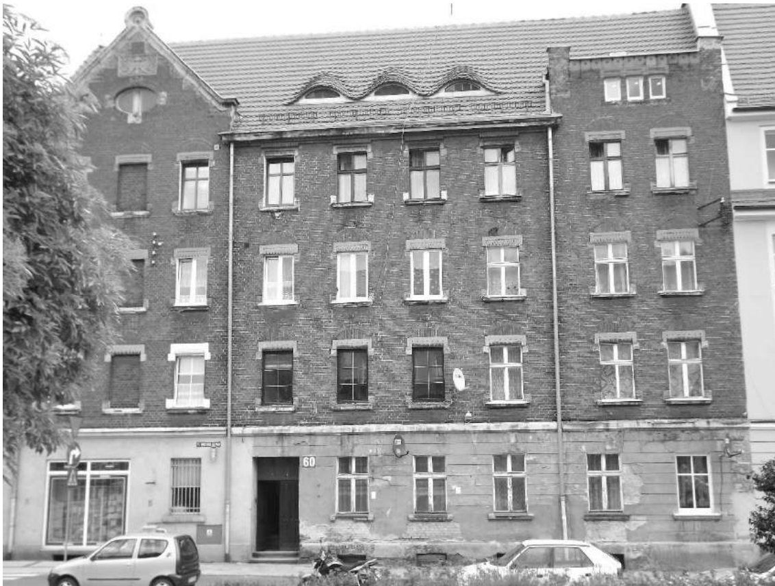
Elewacja frontowa prawa (z wejściem głównym) – uszkodzenia tynku w poziomie parteru i cokołu, uszkodzenia detali architektonicznych i obróbek blacharskich.
