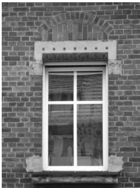
Elewacje frontowe – uszkodzenia sztukaterii, zanieczyszczenia cegieł
