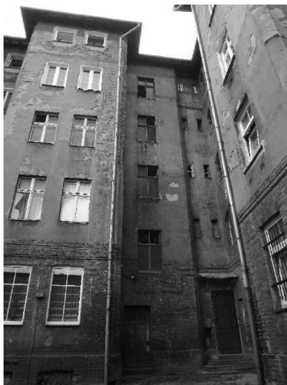
Elewacja tylna lewa: uszkodzone tynki, zdegradowana stolarka klatki schodowej, miejscowe uszkodzenia powierzchni ceglanej
