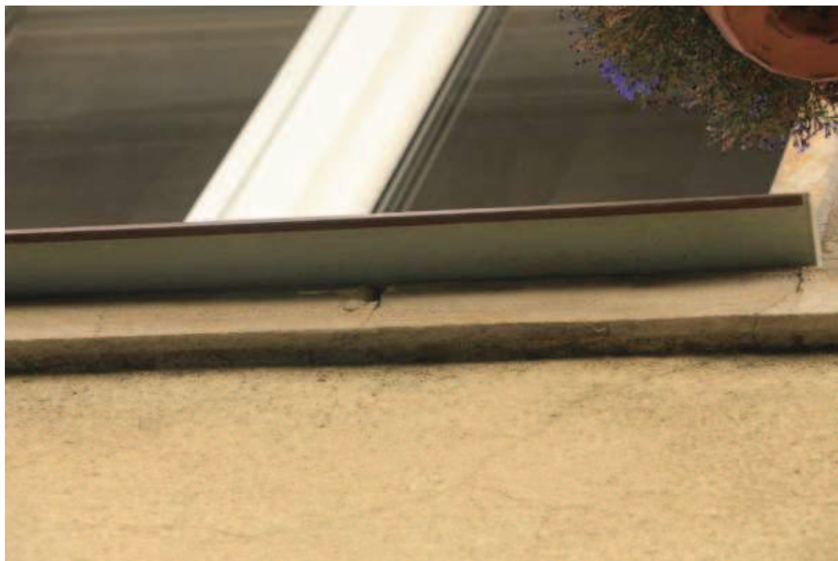
Ryc 7. Niewielka nieszczelność pod parapetem
