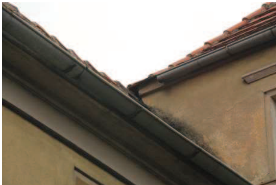
Ryc 5. Ubytki na styku dachu i ściany
