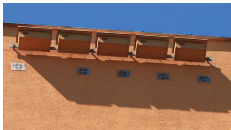
Ryc. 5 Przykładowy sposób zamocowania pięciu budek dla jerzyka do budynku – za pomocą płaskownika i czterech kotew mocujących płaskownik do ściany budynku, przechodzących przez warstwę termoizolacyjną.
