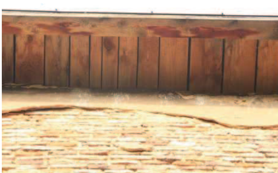
Ryc 4. Ubytki w jednej ze ścian
