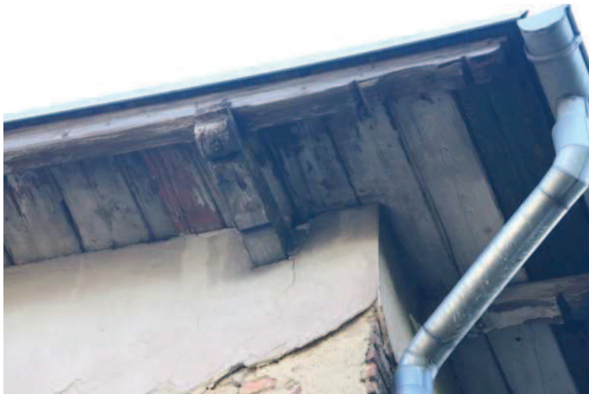
Ryc 6. Ubytki i potencjalne siedliska na styku dachu i ściany 1
