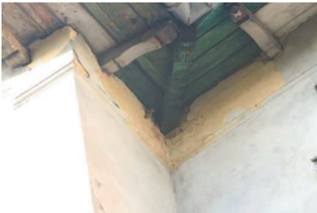
Ryc 8. Ubytki i potencjalne siedliska na styku dachu i ściany 3
