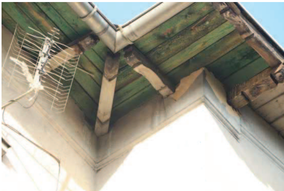
Ryc 9. Ubytki i potencjalne siedliska na styku dachu i ściany 4
