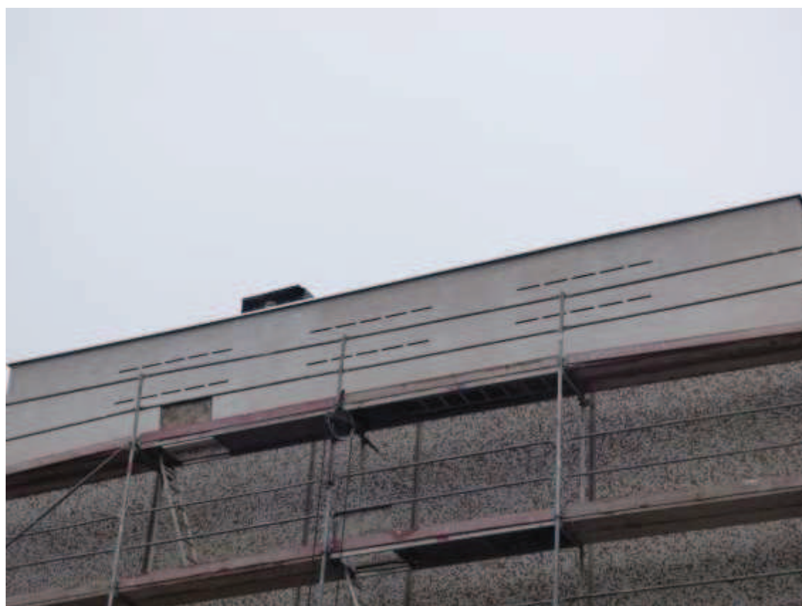
Ryc 13. Budki podtynkowe dla nietoperzy – przykład ściany bloku z 30 dużymi budkami dla nietoperzy. W analizowanym budynku zaleca się montaż 6 tego typu budek.
