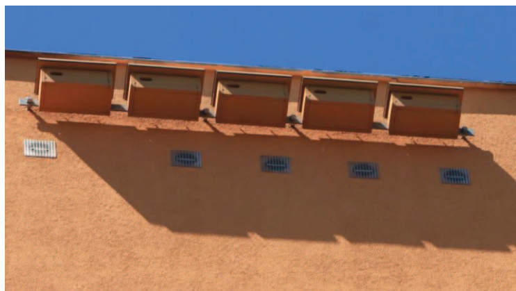
Ryc. 6 Przykładowy sposób zamocowania pięciu budek dla jerzyka typu APK-1 do budynku – za pomocą płaskownika i czterech kotew mocujących płaskownik do ściany budynku, przechodzących przez warstwę termoizolacyjną.
