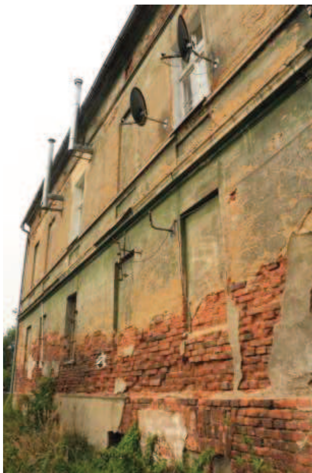
Ryc 4. Ubytki w jednej ze ścian
