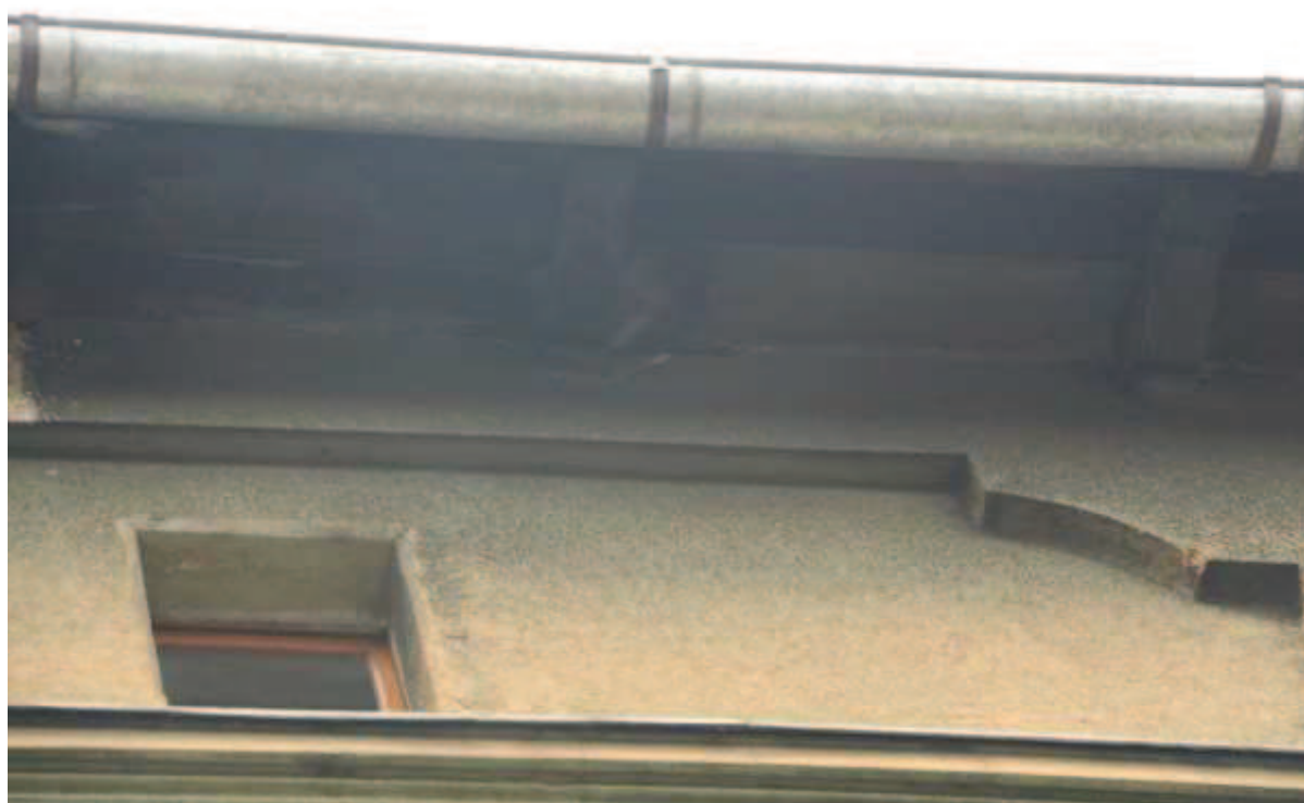
Ryc 5. Ubytki i potencjalne siedliska na styku dachu i ściany 2
