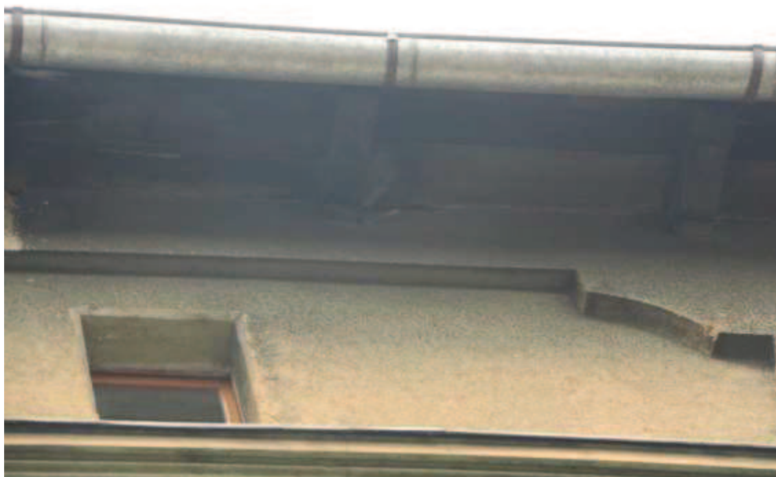
Ryc 6. Ubytki i potencjalne siedliska na styku dachu i ściany 3
