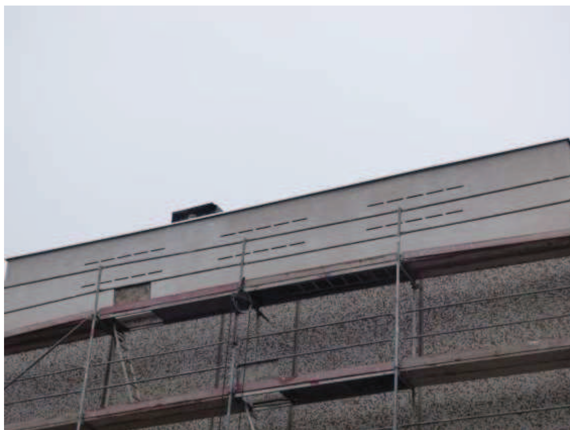
Ryc 9. Budki podtynkowe dla nietoperzy – przykład ściany bloku z 30 dużymi budkami dla nietoperzy. W analizowanym budynku zaleca się montaż 6 tego typu budek.
