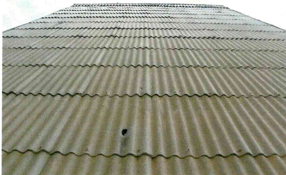
Ryc. 2. Okładzina ściany szczytowej północnej wykonana z eternitu.
