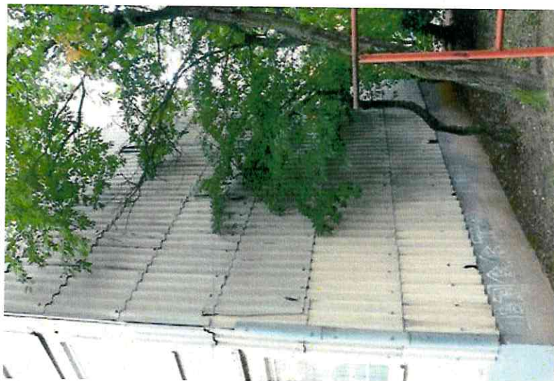
Ryc. 2. Okładzina ściany szczytowej południowej wykonana z eternitu.
