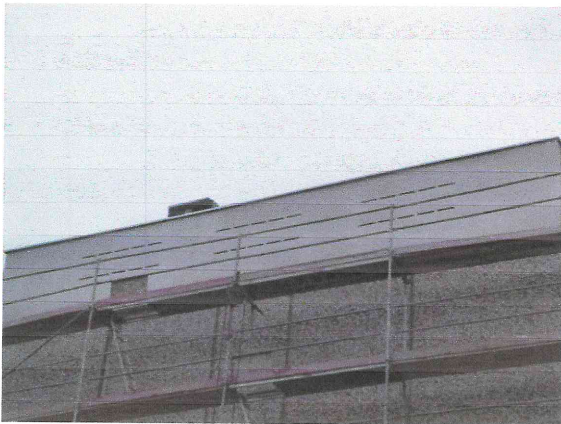
Ryc 6. Budki podtynkowe dla nietoperzy – przykład ściany bloku z 30 dużymi budkami dla nietoperzy. W analizowanym budynku zaleca się montaż 2 tego typu budek.
