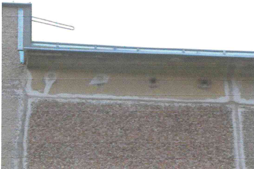
Ryc 3. Otwory do stropodachu i nowe opierzenie
