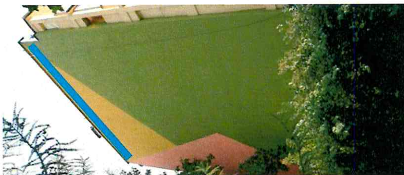
Ryc. 5 Proponowane miejsce zawieszenia budek dla jerzyków na ścianie szczytowej północno części bloku dotyczącej klatki nr 12. Niebieska linia oznacza 22 budki dla jerzyka typu APK-1 w jednym rzędzie (tak jak na Ryc. 6), można je także zawiesić w dwu równoległych rzędach w odległości kilku/ kilkunastu centymetrów nad sobą.
